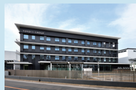
川越製造所の新技術管理棟
