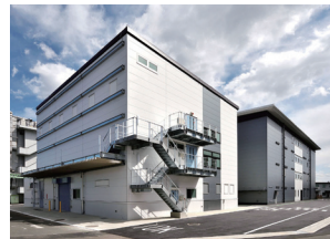
ポリマーパイロット棟
