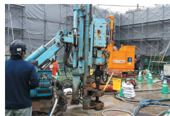
原位置不溶化工事
