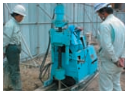
CIを用いた注入工法
