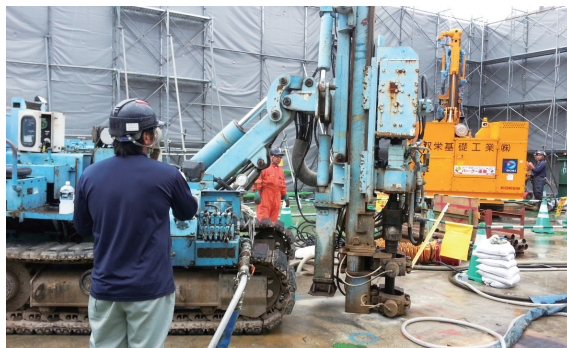
原位置不溶化工事(東洋FPP(株)北海道事業所)
