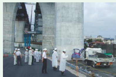
学識経験者の方々による施工状況見学
