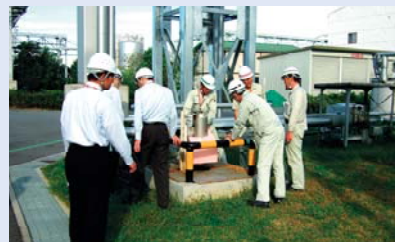
守山製造所での現場確認
