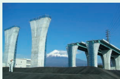
汚染土壌対策措置が完了した第二東名高速道路用地
