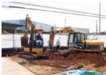
汚染土壌の掘削・除去作業
