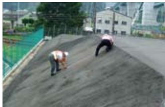
第二東名高速道路建設用地での措置
