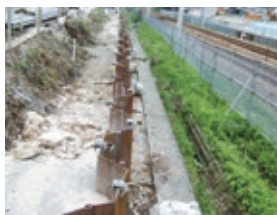
遮水壁の設置工事
