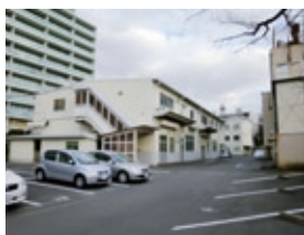
新ビル建設予定地
