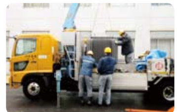
微量PCB含有トランスの移動作業(先端材料研究所)
