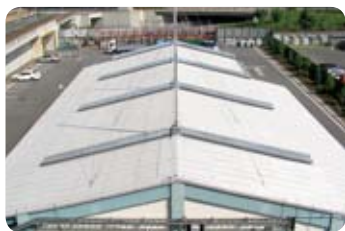
寝屋川センターの遮熱塗装
