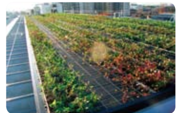
川口センターの屋上緑化
