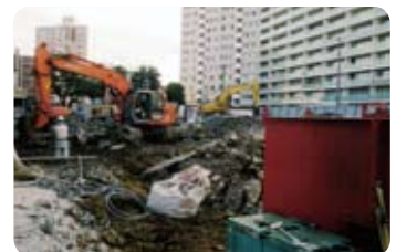
新ビル建設予定地での解体作業
