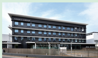
「Nearly ZEB」認証の技術管理棟
