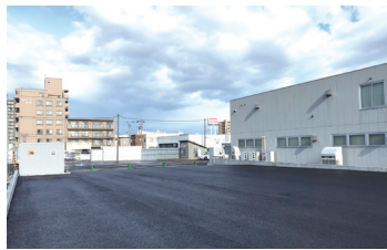
汚染土壌の掘削移動工事完了後の様子 (東洋FPP(株)北海道事業所跡地)
