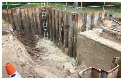
汚染土壌の掘削除去工事 (東洋インキSCホールディングス(株)先端材料研究所)
