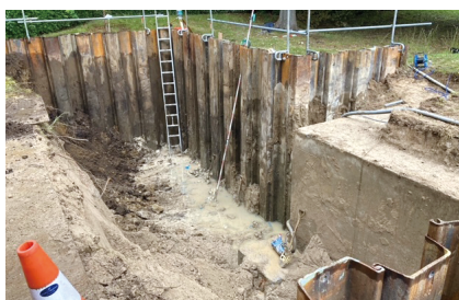
汚染土壌の掘削除去工事 (東洋インキSCホールディングス(株)先端材料研究所)
