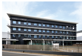
「Nearly ZEB」認証の技術管理棟
