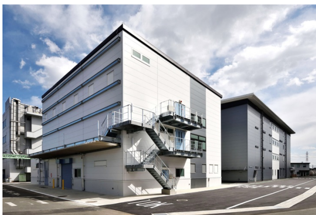
川越製造所ポリマーパイロット棟(手前)
